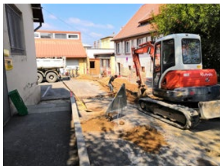
Gros chantier devant les bureaux pour créer la zone stationnement handicap.
